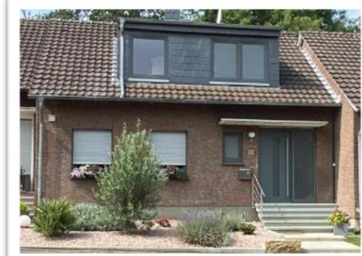
125 m 2 Mäßig gedämmt Flächenheizung 8 kW
