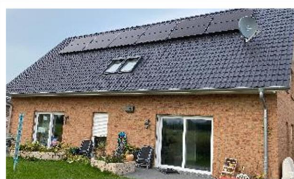
140 m 2 Prima gedämmt PVT und Flächenheizung 6 kW
